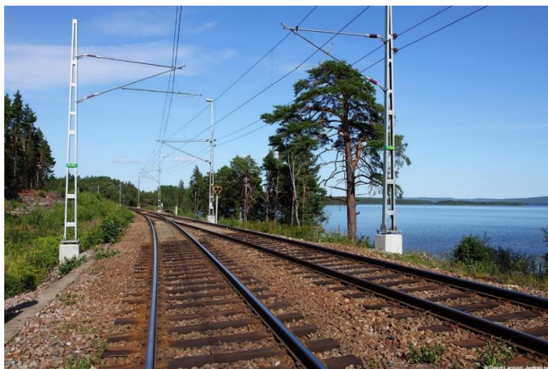
Norra änden av driftplatsen Hinsnoret med vacker utsikt över sjön Runn på den hårt trafikerade delen av Bergslagsbanan mellan Borlänge och Falun. Planer på en helt ny järnväg mellan städerna ligger tills vidare på is.
