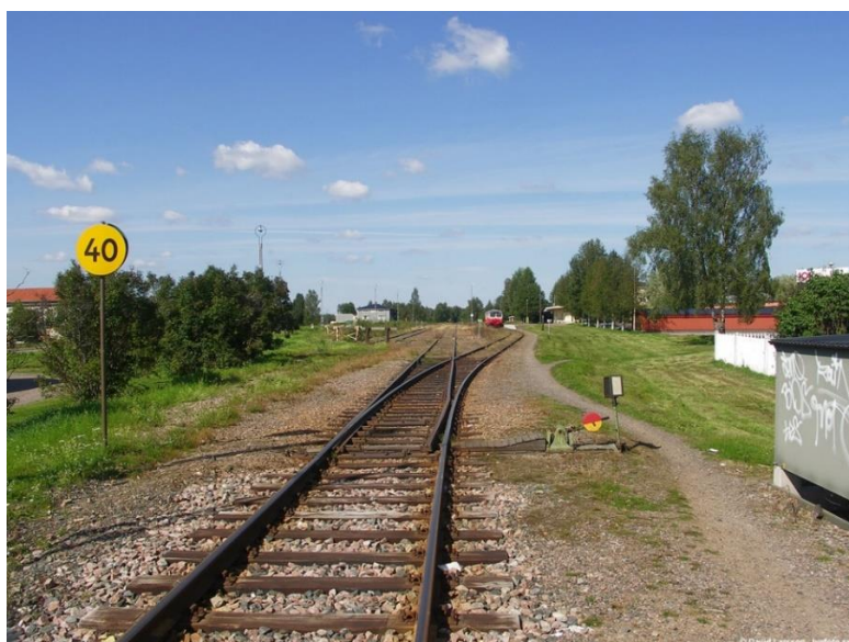
Bangården i Malung sedd från infarten från Vansbro-hållet. Trafiken med resandetåg är numera nedlagd men banan fortsätter ytterligare någon mil norrut till sågverket i Malungsfors.
