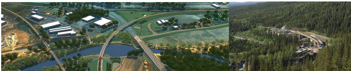
Bergsåkerstriangeln (v). Det nya triangelspåret till höger, Ådalsbanan till vänster, Mittbanan i överkant. Den nya bron vid Stora Helvetet under byggnad 2017 (h). Foton Trafikverket.
