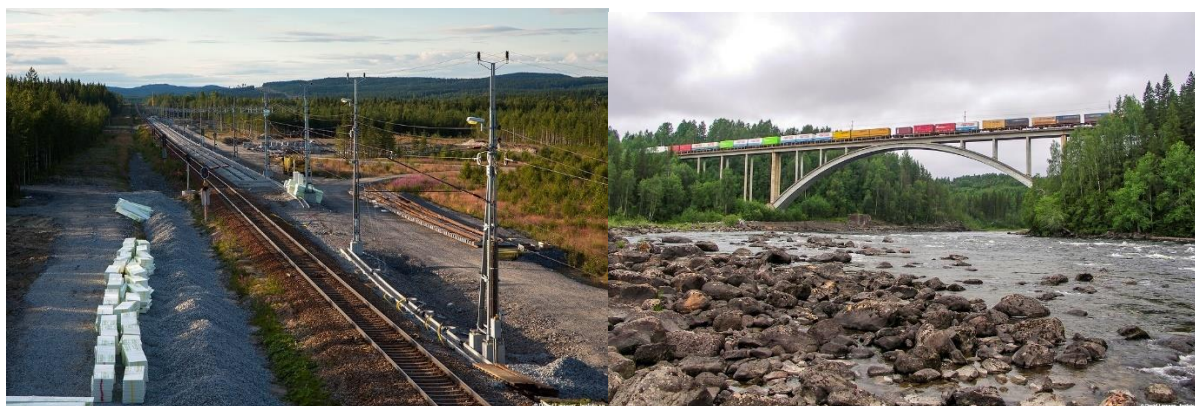
T.v. Den södra gränsen för Bodens trafikledningsområde går vid Vännäs norra, ett mötesspår strax norr om tringelspåret vid Vännäs. En bild från bygget av mötesspåret, som stod klart 2012. Foto David Larsson.
