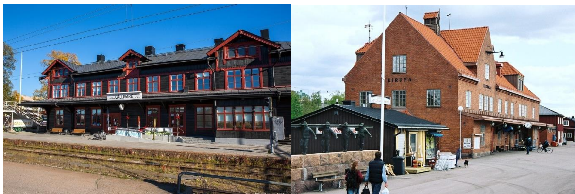
T.v. Gällivare station före bangårdsombyggnaden. Numera finns endast perrong vid spår 1 närmast stationshuset. Foto David Larsson
