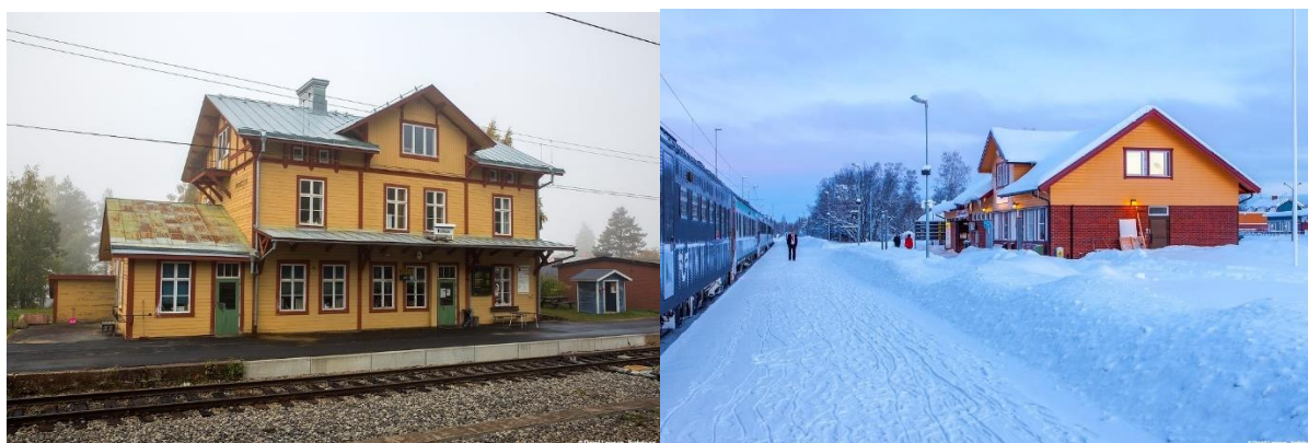
T.v. Stationshuset i Hällnäs med perrong vid avvikande huvudspår. Strax norr om stationen avviker tvärbanan till Lycksele och till Storuman vid Inlandsbanan. Foto David Larsson.
