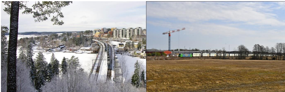
T.v. Den sista etappen av dubbelspår, mellan Kallhäll och Kungsängen, blev klar 2001. Här infarten till Kungsängen söderifrån. Foto Markus Tellerup.
