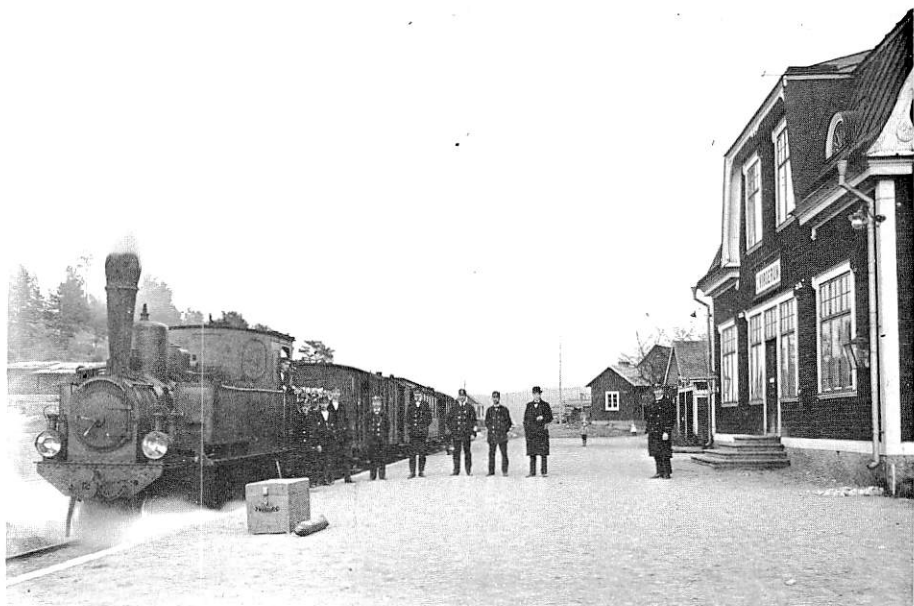
Fig 13. Virserum station omkring 1920. VÅHJ lok 5 med persontåg mot Växjö. Foto: SJK Fotoavdelning.
