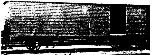
DONJ 150 litt G Ursprungligen en av de långa arbetarvagnarna, som fått en ny bredare dörröppning och igensatta sidor för massatransport. Ockelbo 1963.
