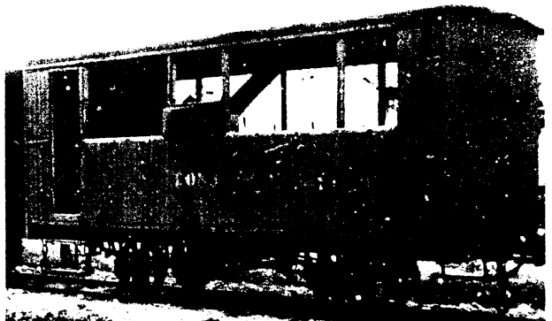
DONJ 205 litt CN En av de korta arbetarvagnarna, byggd av DONJ verkstad 1901. Skruvbroms mitt på långsidan, som blev nyckelbroms om man på vintern lyfter av skrovet och satte på stolpar i stället. Jädraås 1953.
