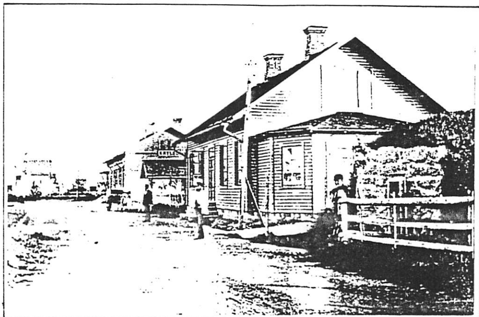
Krylbo första järnvägsstation från gatusidan år 1899. Byggd år 1874.
