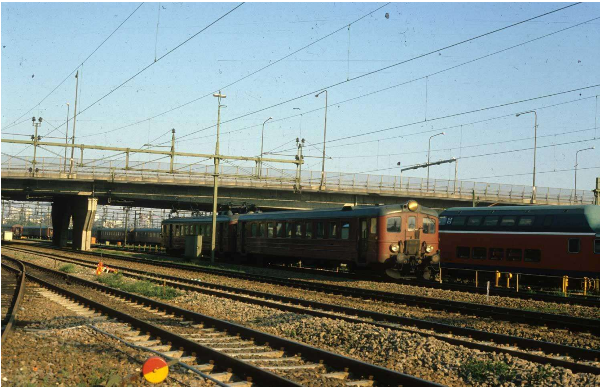
Malmö bangård, vy mot Frihamns- viadukten
