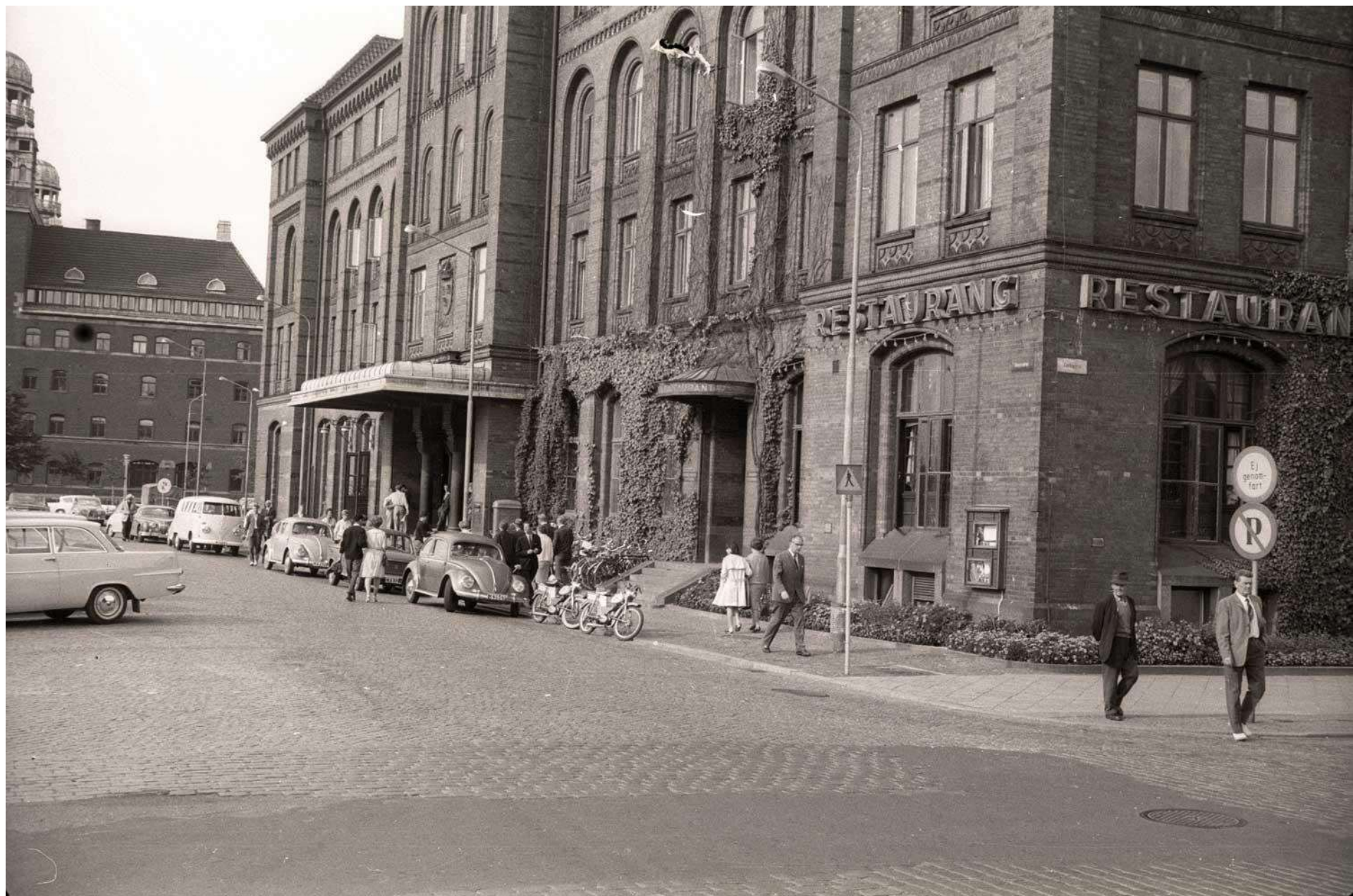
Malmö C, fasad mot Skeppsbron
